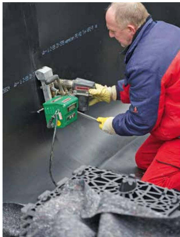
La membrana impermeabile viene termosaldata
