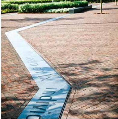
Le due fessure adiacenti da 8 mm delle caditoie SlotTop Double corrono parallele offrendo una maggiore superficie di captazione delle acque ed enfatizzando le geometrie delle pavimentazioni.
