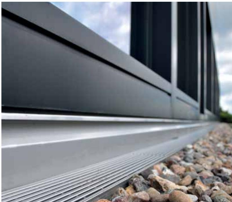
ACO Profiline nasce espressamente per il drenaggio dell'acqua in prossimità di facciate o su terrazzi, balconi, tetti piani, tetti verdi e giardini pensili. E' la soluzione ideale in grado di unire funzionalità e design. E' stato studiato per inserirsi perfettamente su pavimenti decking, flottanti, o pavimentazioni con strato drenante.
