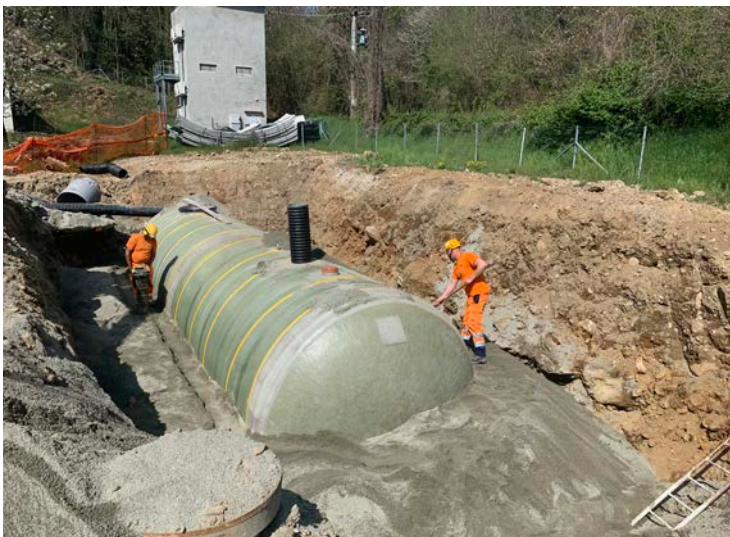
Posa di una cisterna di accumulo ACO in GRP
