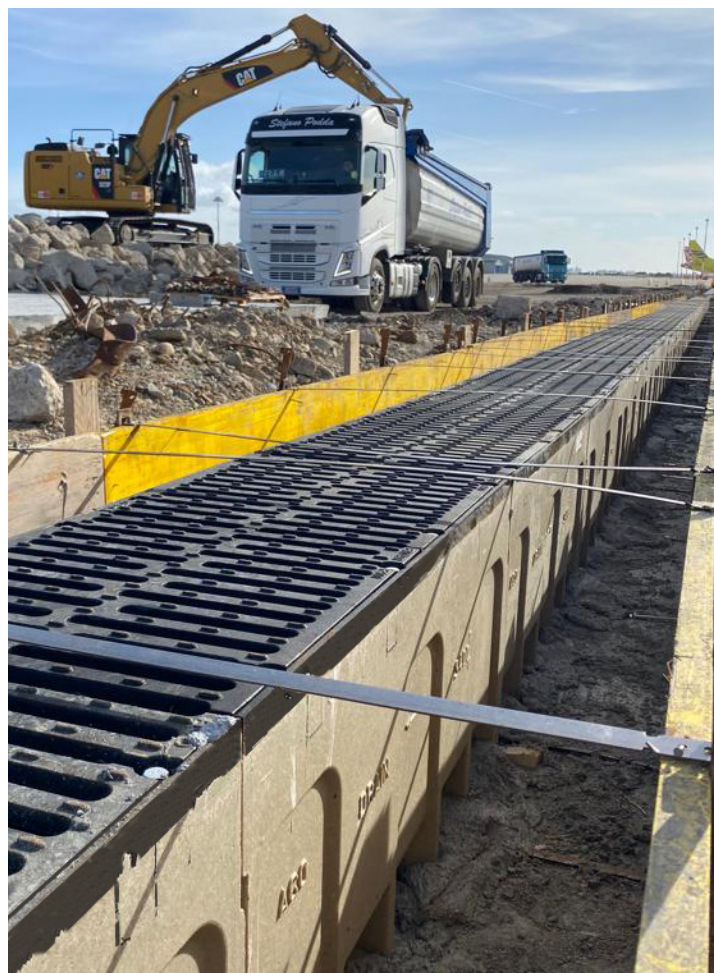
Nella foto: installazione del sistema ACO Serie S con griglia a ponte
