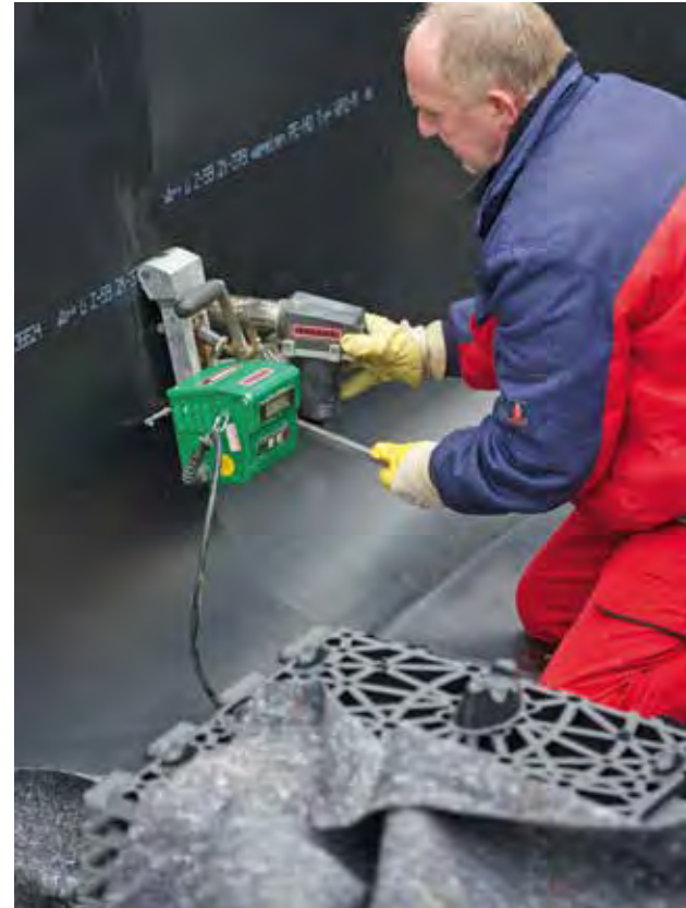
La membrana impermeabile viene termosaldata
