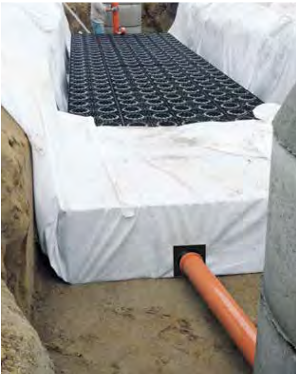
Il geotessuto protettivo viene avvolto attorno all'intero sistema d' infiltrazione
