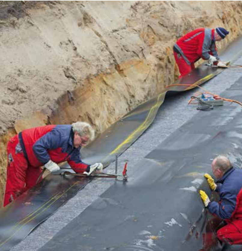
Il sistema di stoccaggio è avvolto con uno strato di tessuto protettivo interno e una membrana impermeabile di tenuta
