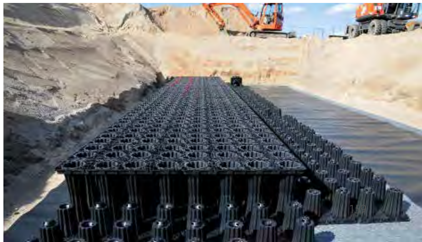
Il geotessuto protettivo viene avvolto attorno all'intero sistema d' infiltrazione
