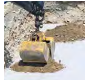
Riempimento dello scavo contenente il sistema d'infiltrazione
