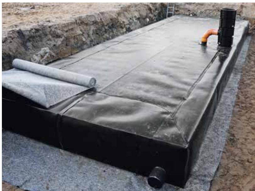
Infine, la membrana impermeabile viene ricoperta da uno strato di protezione esterno
