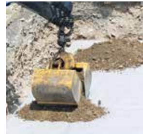
Riempimento dello scavo contenente il sistema d'infiltrazione
