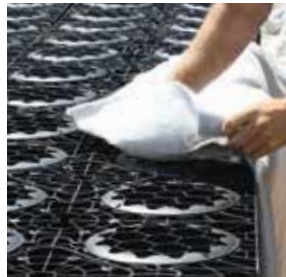
Il geotessuto protettivo viene avvolto attorno all'intero sistema d' infiltrazione
