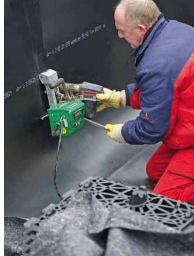
La membrana impermeabile viene termosaldata
